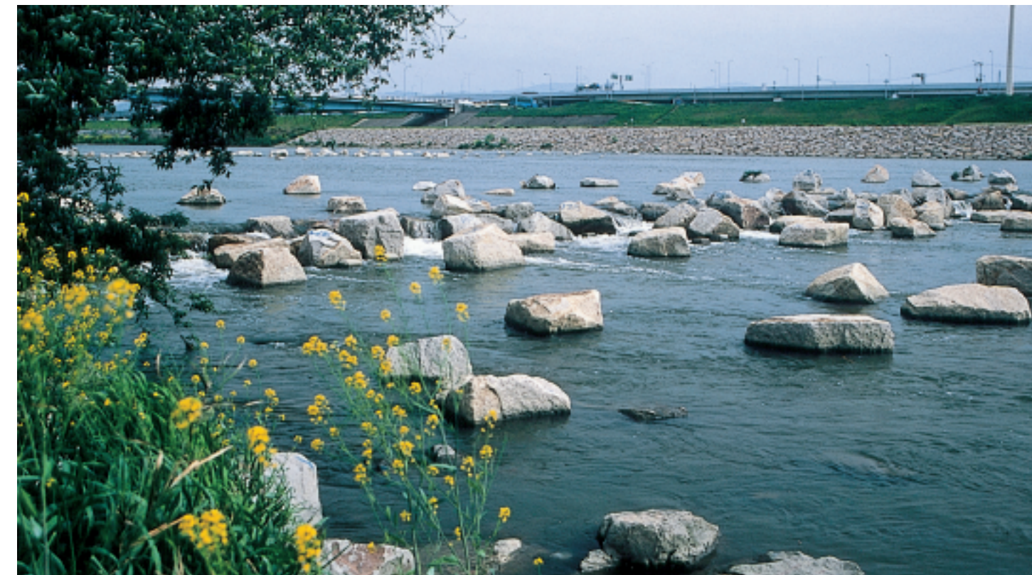
瀬と淵浄化方式（大和川下流浄化施設）
