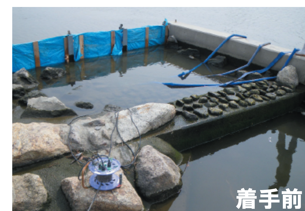
着手後 流量を増やすために、隔壁を一部けずりました
