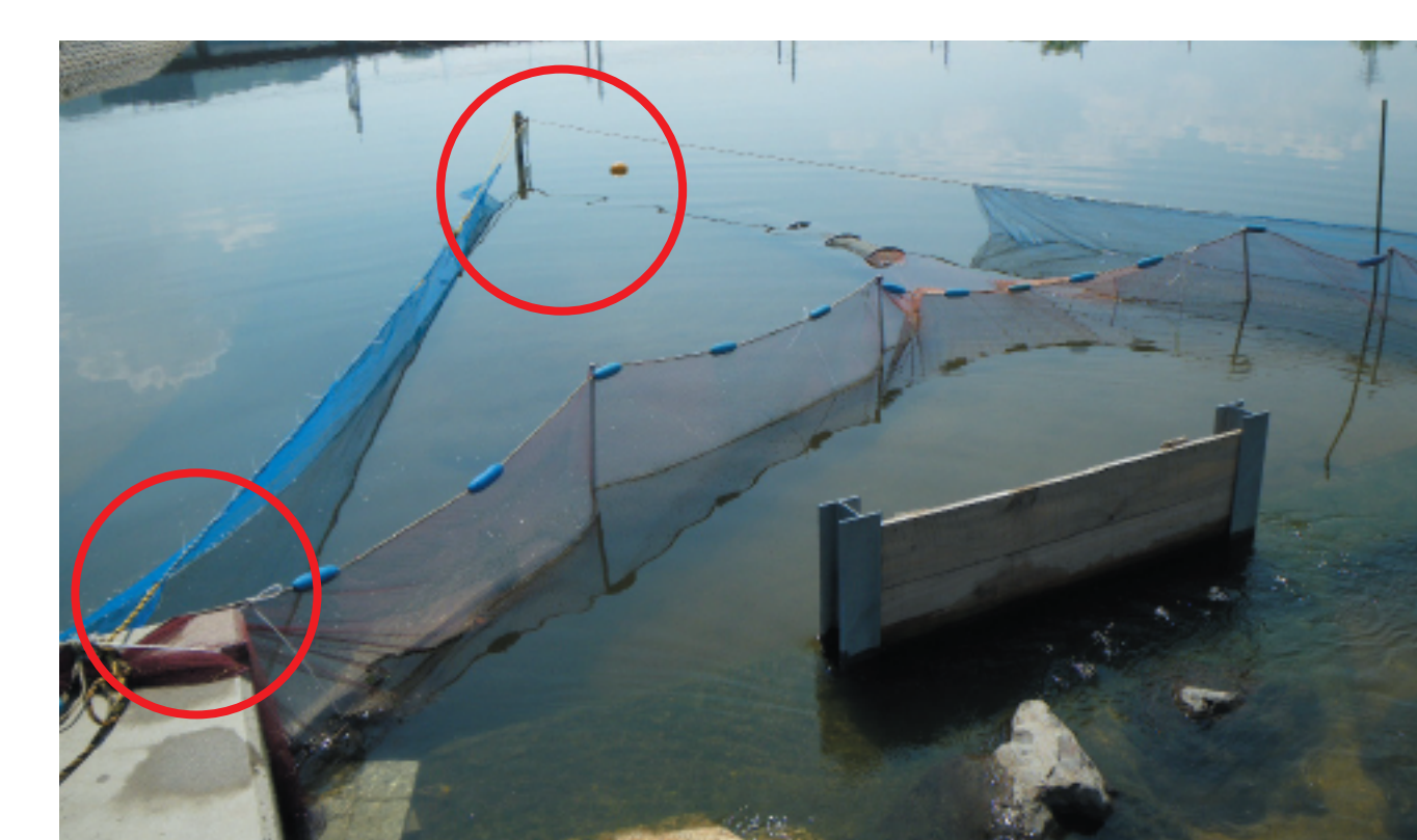
取付金具等の設置
