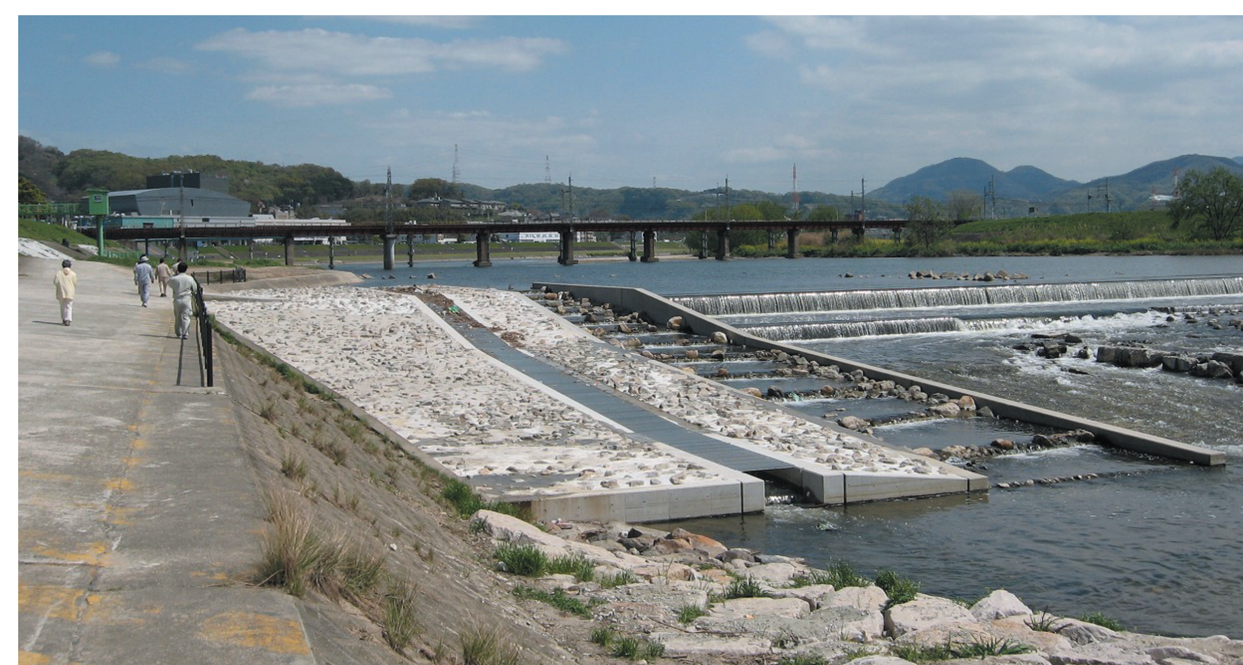
平成22年3月に完成した柏原堰堤右岸魚道
