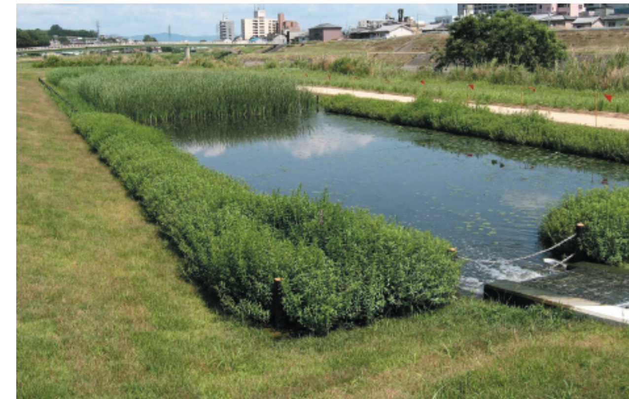
植生浄化方式（信貴川浄化施設）
